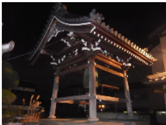
除夜の鐘の西光寺鐘樓
